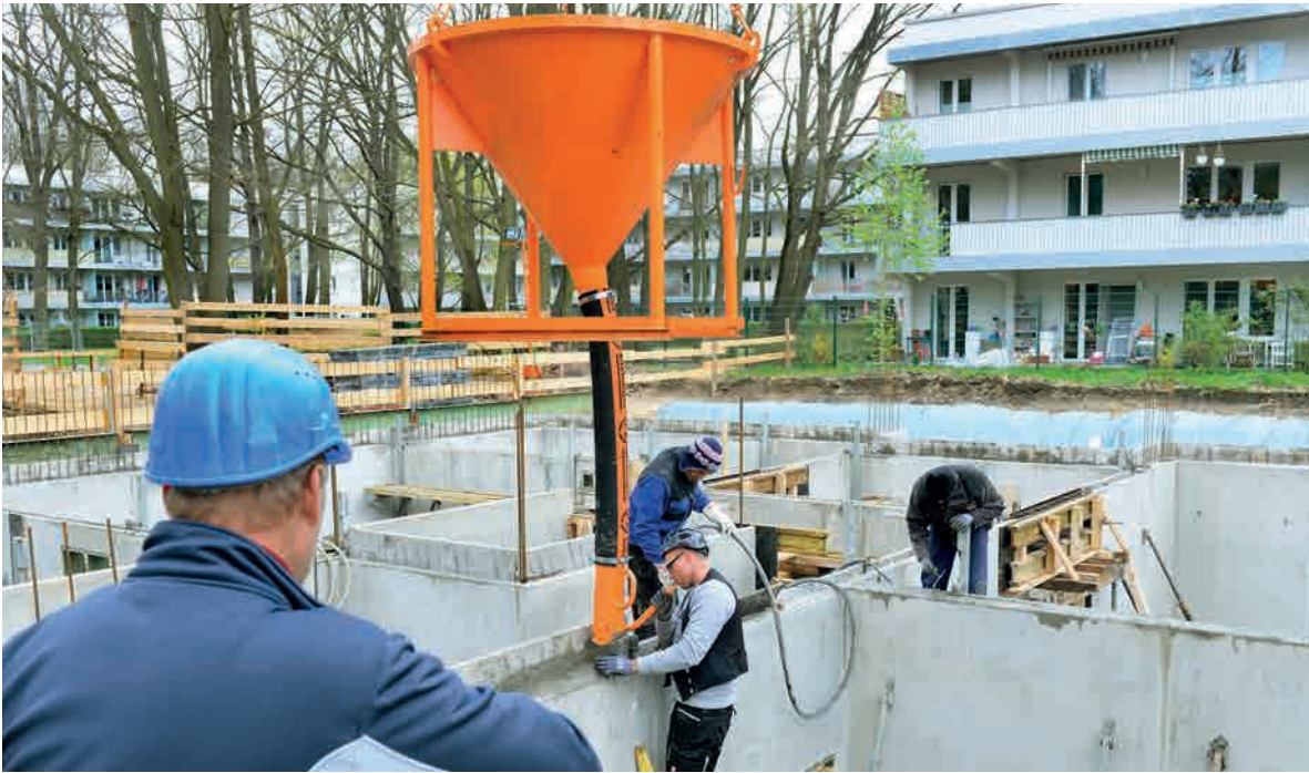
Im ersten Baufeld haben die Hochbauarbeiten begonnen
