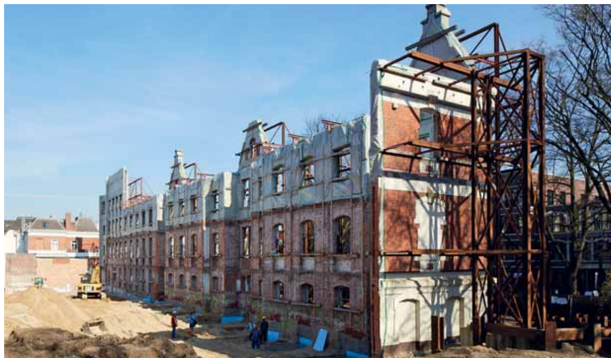
Hinter der historischen Fassade des Krankenhauses entsteht ein Zentrum für Kultur sowie neue Wohnungen
