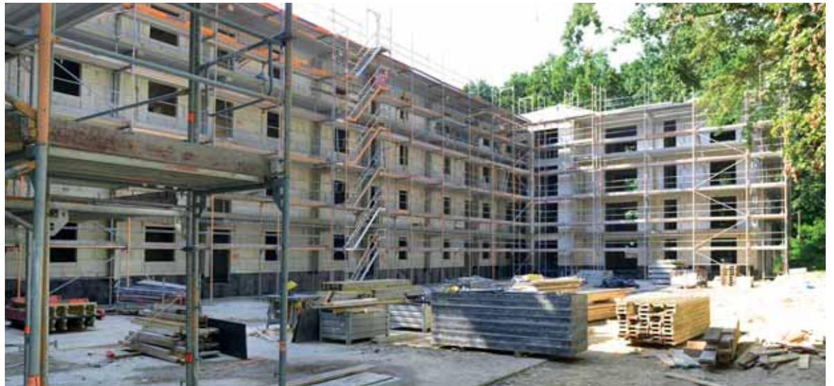
In der Straße Zum Jagenstein 1 A/B wird im Oktober Richtfest gefeiert
